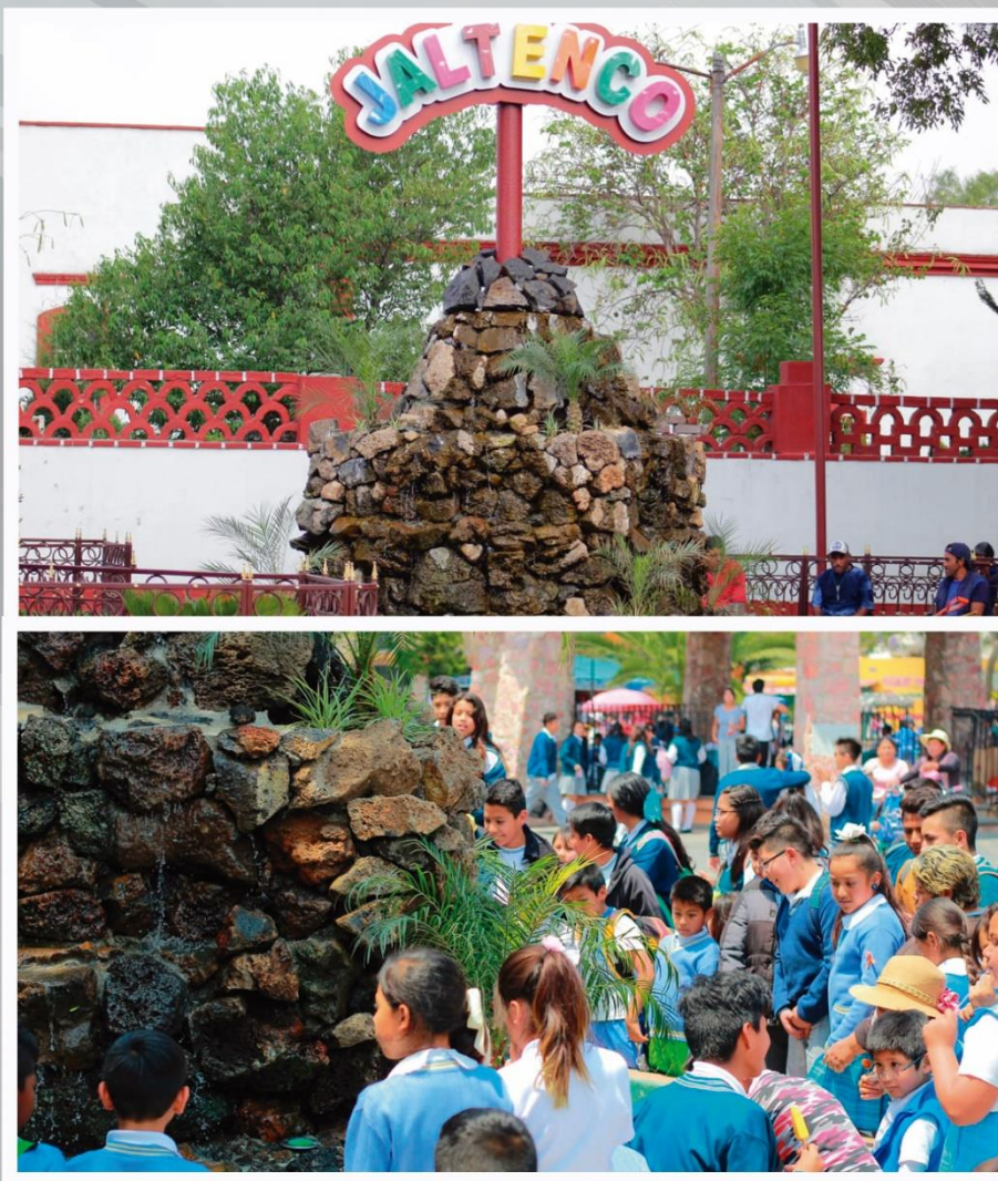
Construcción de fuente con cascada de agua en la Plaza Principal de San Andrés Jaltenco.
